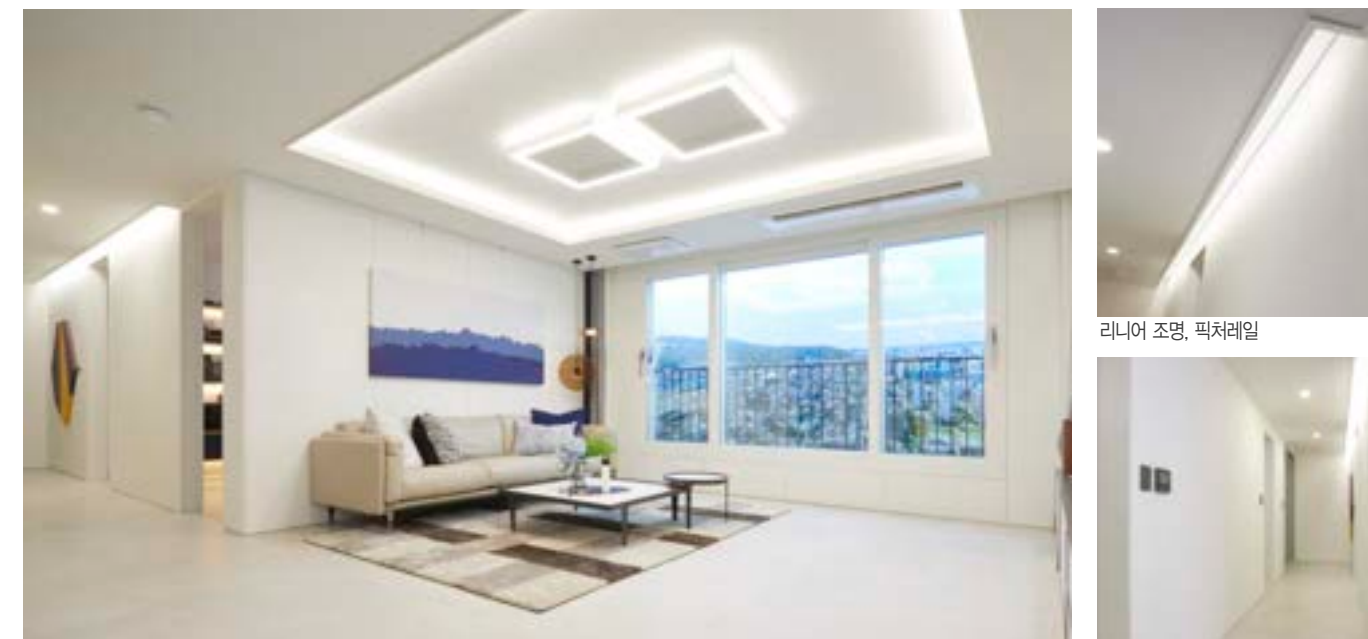
거실 우물천장 내 간접조명, 리니어 조명, 픽처레일, 시트패널
